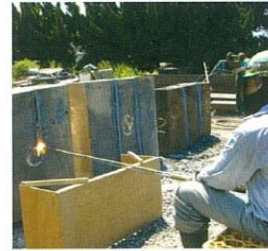
■ 極電スラブ切断
